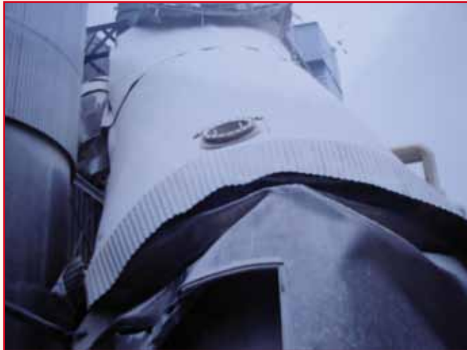
Figuur 3: Een aluminium silo die door het lokaal plooien van het onderste deel van de cilinderwand is omgevallen
